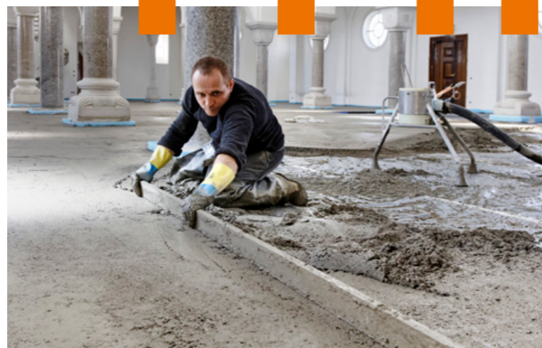
Mit PCI Novoment® Z1 hergestellte Estriche sind bereits nach ca. 3 Stunden begehbar und schon nach ca. 1 Tag mit keramischen Belägen belegbar.
