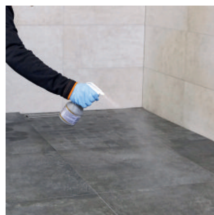
Vor dem finalen Waschgang wird nach ca. 60 Min. PCI Durapox Finish (flüssig) auf die Fläche aufgesprüht.
