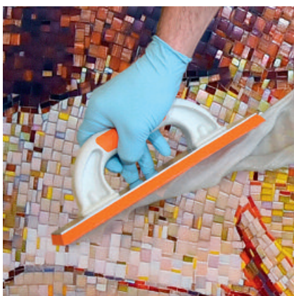
PCI Durapox® Premium Harmony mit einer Hartgummifugscheibe in die Fugen einbringen.
