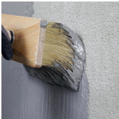
Aufbringen einer Kontaktschicht mittels Bürste oder Quast.
