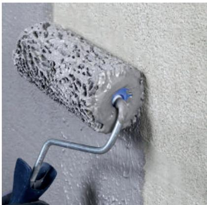
Aufbringen einer Kontaktschicht mit dem Roller.
